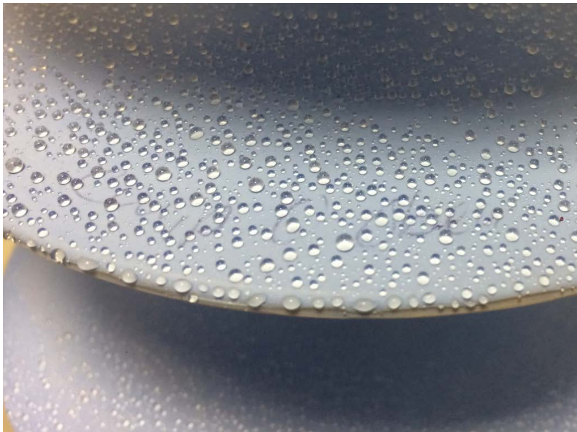
Kieselgur nach Variante 1 (beide Isolatoren → gleicher optischer Zustand)
